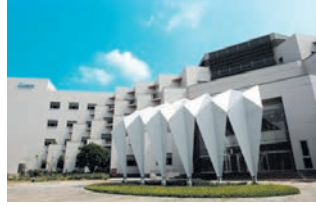
Tainan Fabrika (Elmas Sınıfı Yeşil Bina)
